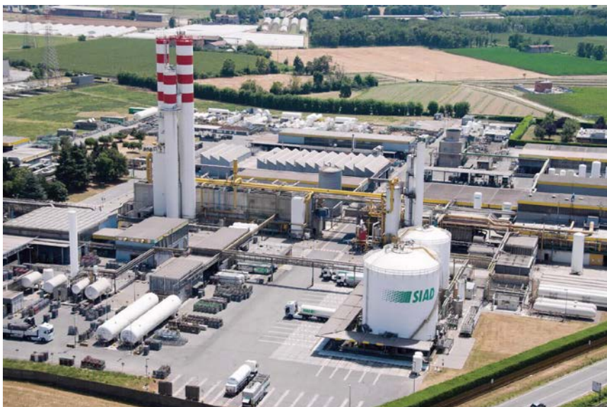
Lo stabilimento di Osio Sopra (BG), il principale centro di produzione SIAD, rappresenta il più grande ed articolato insediamento nazionale nel settore dei gas tecnici
