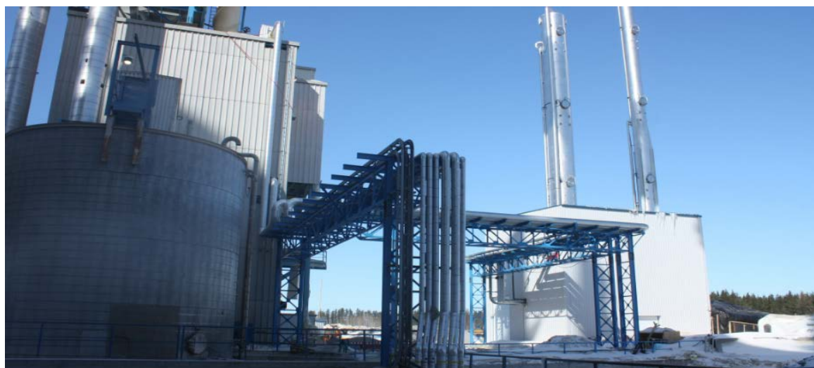
Impianto di Cattura CO2 da 30 tonnellate al giorno operativo su scala commerciale a Saint-Felicien, Quebec, Canada
