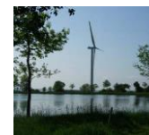
LES CRETES 10MW
