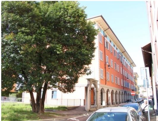
Vista edificio da via V. Emanuele II
