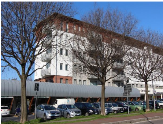
Vista edificio da via V. Emanuele II
