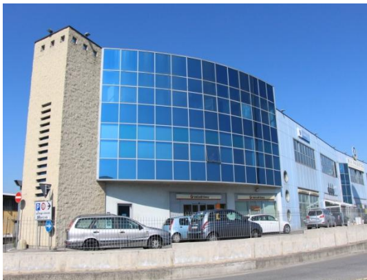
Vista edificio da via Balilla
