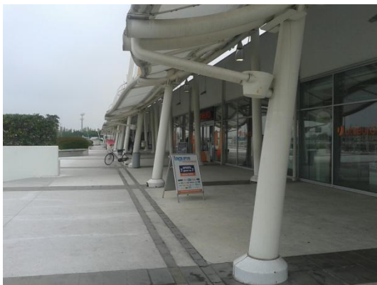
Area porticata piano primo
