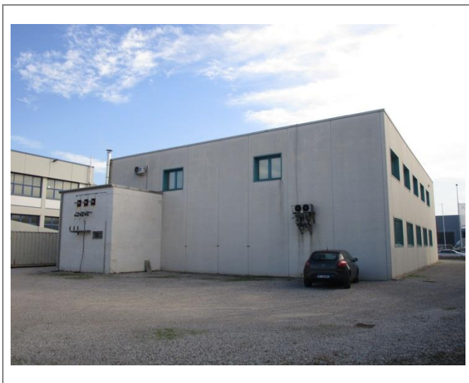
Padova (PD) – Via Germania, 28 Vista esterna - Prospetto posteriore
