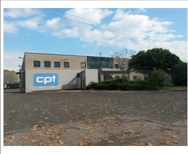
Patrica (Fr) – Via Morolense Snc Vista esterna - Prospetto principale
