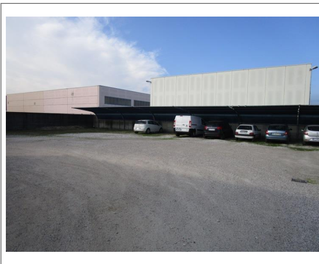
Padova (PD) – Via Germania, 28 Vista esterna – Area di manovra e tettoia
