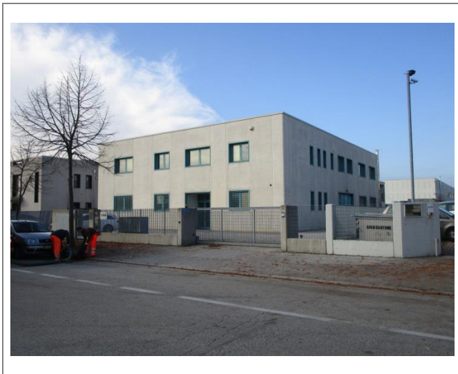
Padova (PD) – Via Germania, 28 Vista esterna - Prospetto principale
