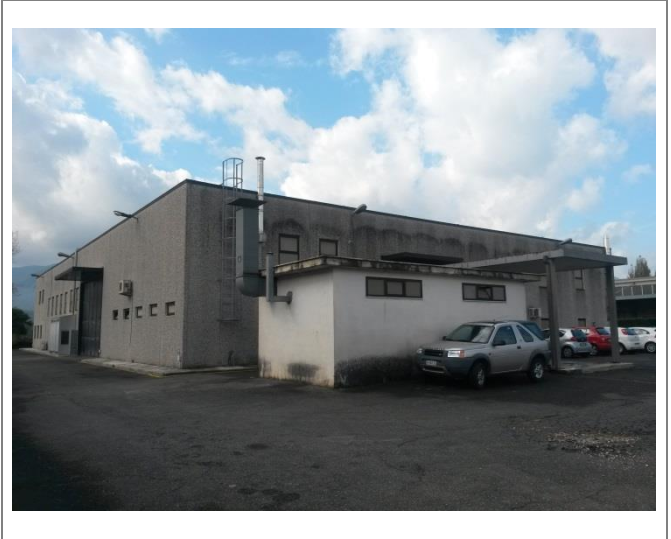
Patrica (Fr) – Via Morolense Snc Vista esterna - Prospetto posteriore
