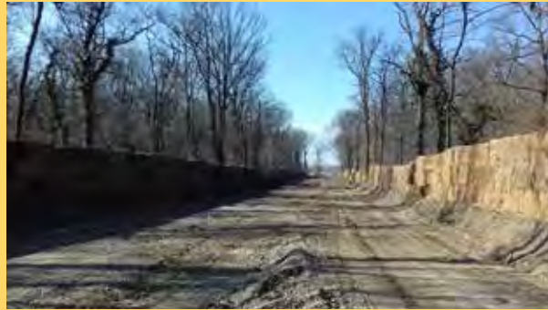
Bosco del Modrone: apertura della pista di lavoro e posizionamento delle barriere antirumore
