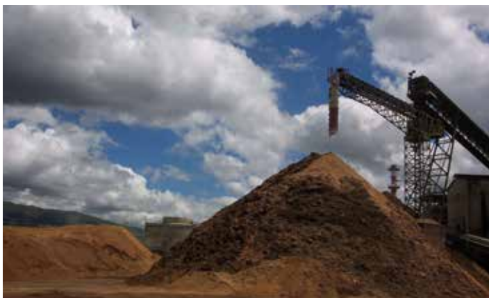
Impianto a biomasse e fotovoltaico di Rende (Cosenza)
