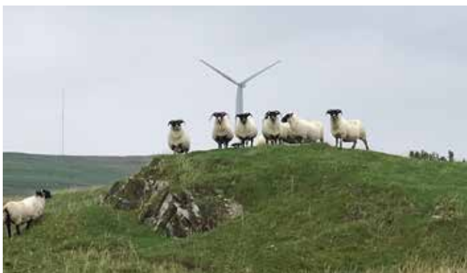
Parco eolico di Auchrobert (Gran Bretagna)
