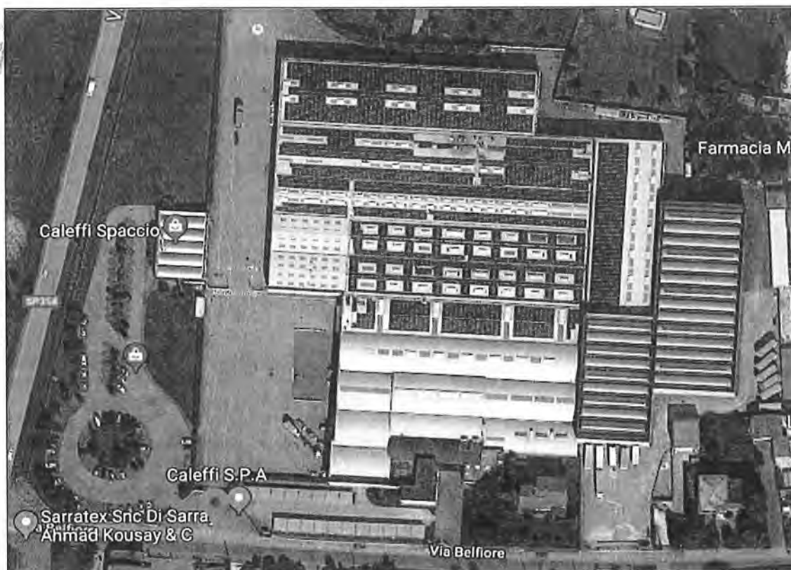
Vista aerea dello stabilimento
