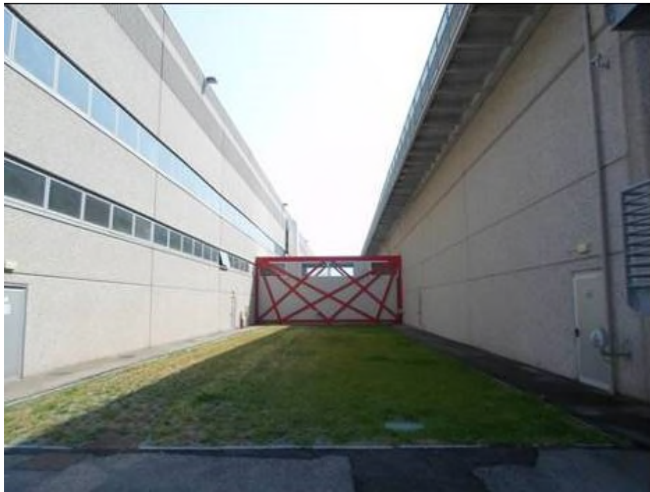
Tunnel di collegamento edifici A e B - esterni
