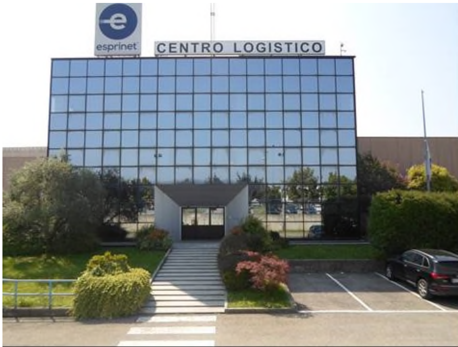
Palazzina uffici – prospetto principale
