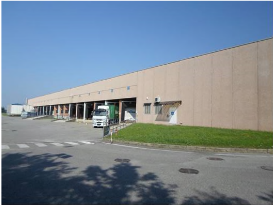
Baie di carico – ricevimento merci
