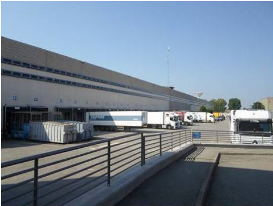
Edificio "Cavenago A" – fronte nord
