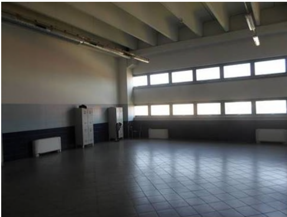
Edificio "Cavenago A" – Spogliatoi piano primo
