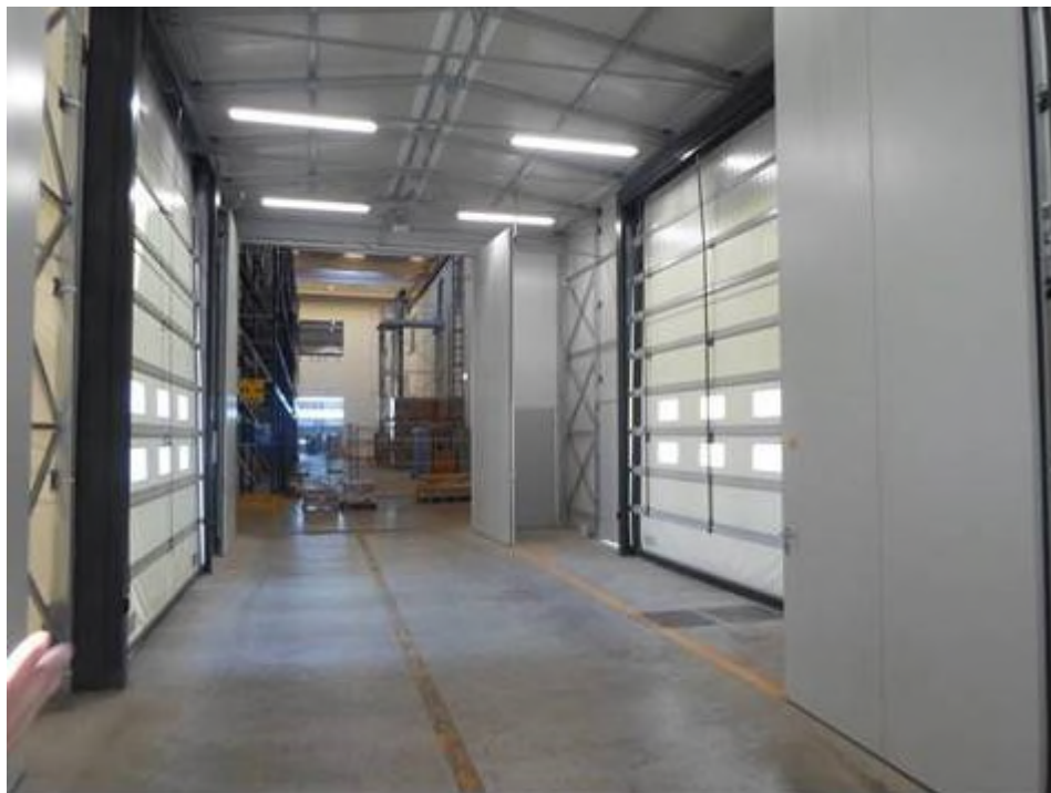
Tunnel di collegamento edifici A e B
