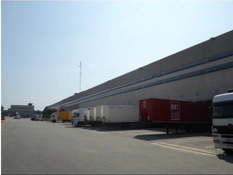
Edificio "Cavenago A" – fronte nord
