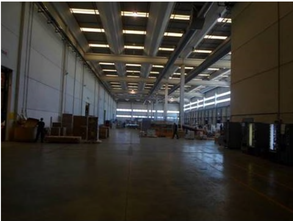
Edificio "Cavenago A" – Magazzino
