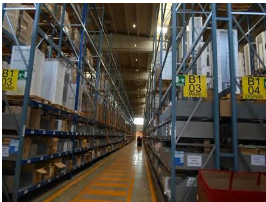
Corpo centrale - Magazzino
