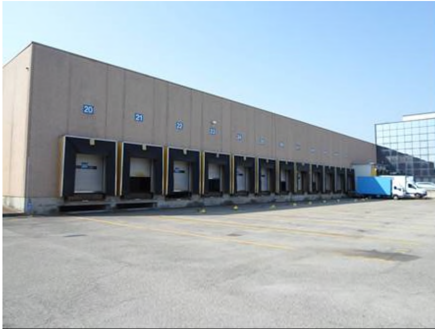
Esterni fronte principale - Baie di carico, spedizione
