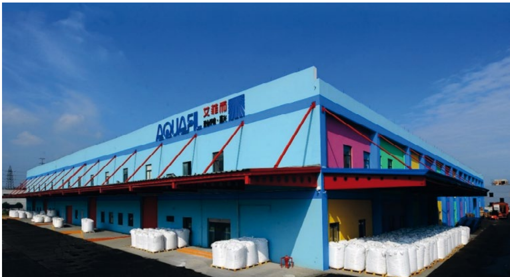
Figura 17 - Impatto visivo dello stabilimento cinese di JIAXING
