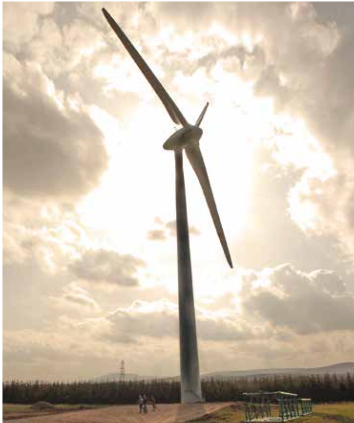
Parco eolico di Boyndie (Gran Bretagna)
