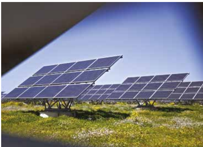
Impianto fotovoltaico di La Calce (Solar Mesagne-Brindisi)
