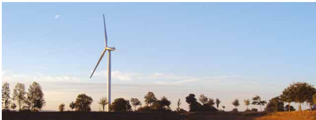
Parco eolico Les Cretes (Francia)
