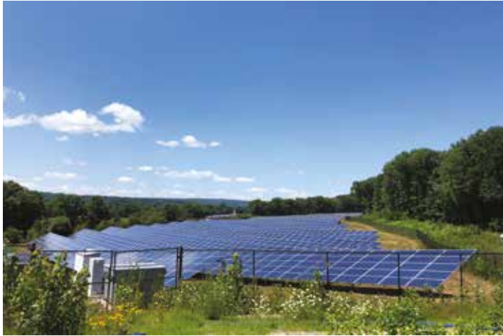
Impianto fotovoltaico Massachusetts
