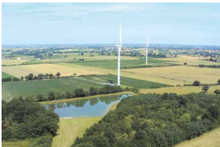
Parco eolico Le Fouy (Francia)
