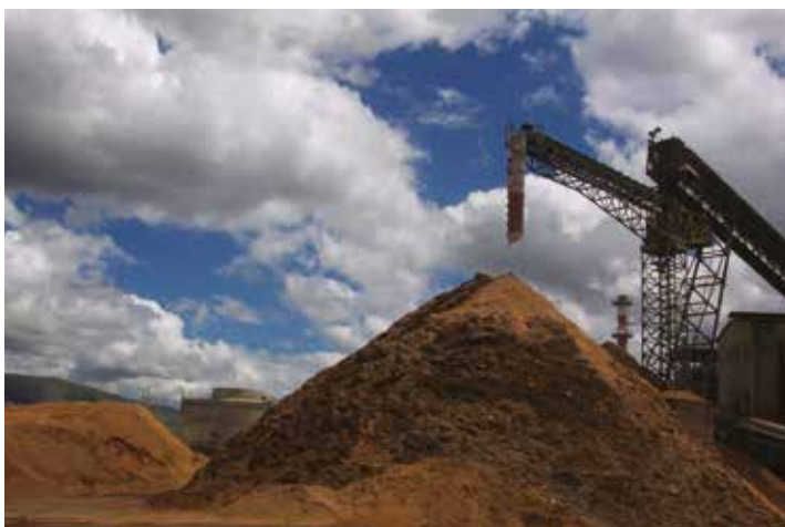
Impianto a biomasse e fotovoltaico di Rende (Cosenza)
