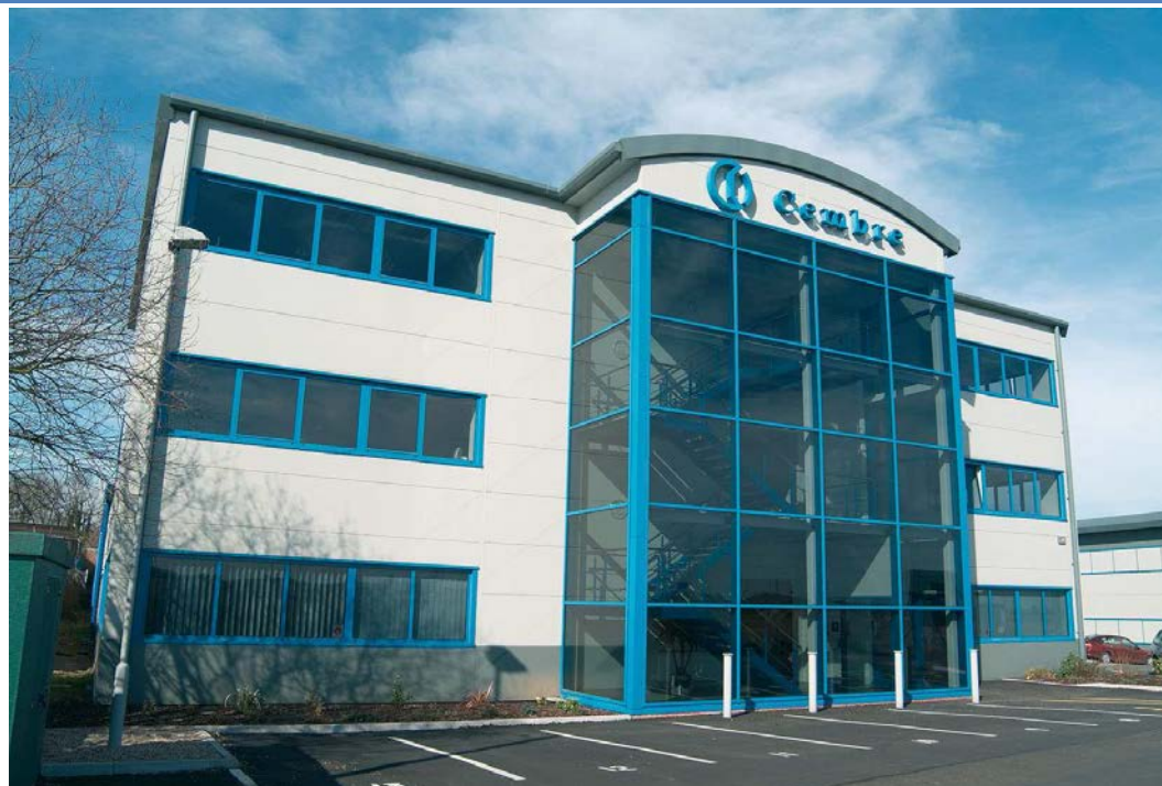
Cembre Ltd. La sede di Curdworth Birmingham (UK)
