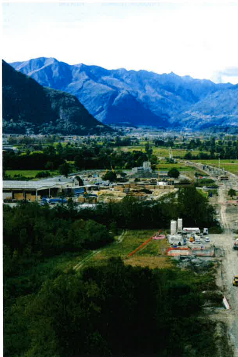
Opere di fondazione per l'Ente tecnico Pedemontana - Italia
