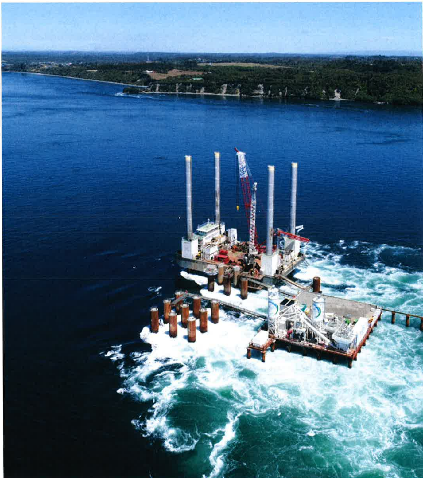
Opere di fondazioni per il Ponte di Chiavari, Clic
