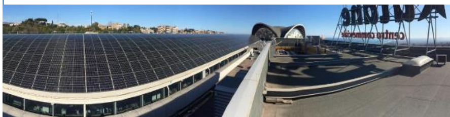
Nuovo impianto fotovoltaico a Katanè
