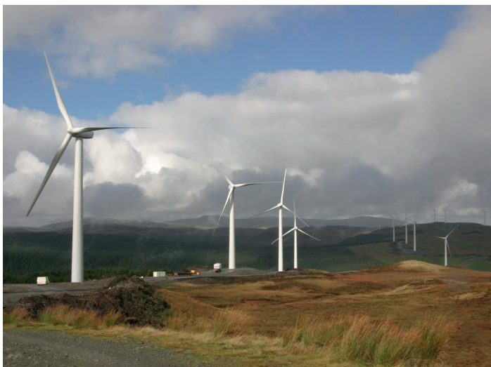
Parco eolico di Cefn Croes (Gran Bretagna)
