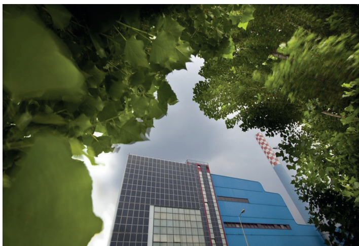
Termovalorizzatore di Trezzo sull'Adda (MI)
