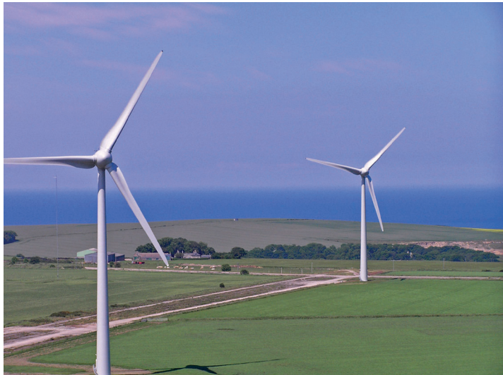
Parco eolico di Boyndie (Gran Bretagna)
