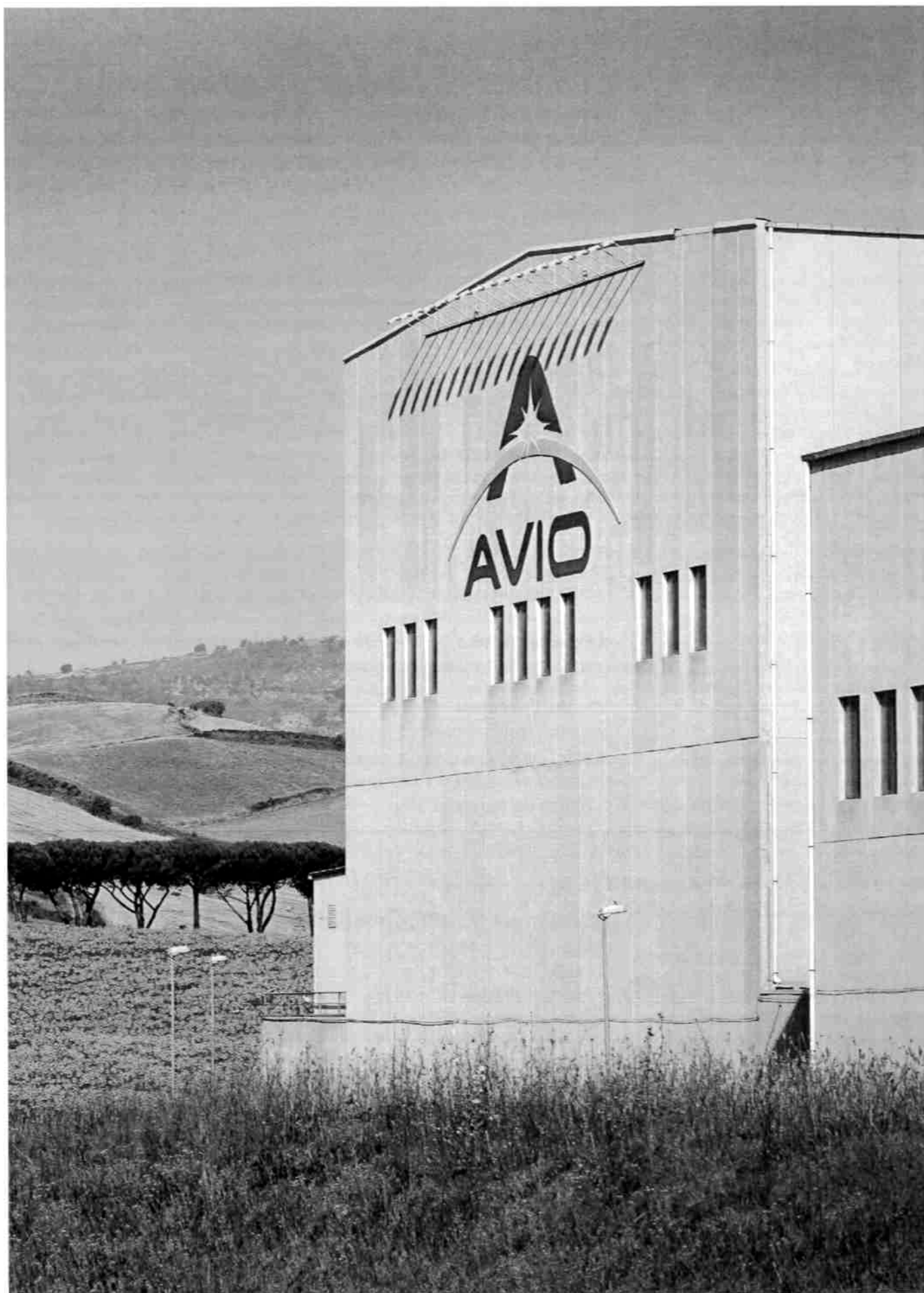
Stabilimento Avio di Colleferro
