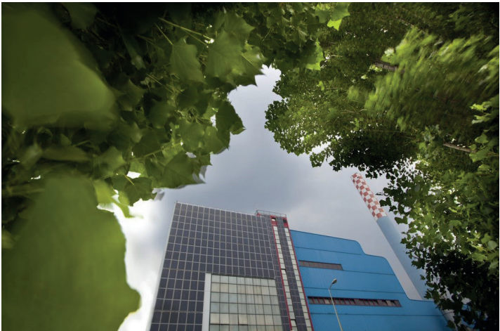
Trezzo sull'Adda (Milan) WtE plant
