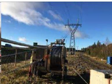
Figura 2 – Macchina digitale al lavoro per la sostituzione del conduttore ACRSS da 31,5 mm con nuovo conduttore ACPR Lo-Sag Nexans con anima in carbonio del diametro di 37 mm sulla linea di interconnessione 400 kv Horta-Avelin in Belgio – 2020
