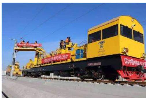
Figura 8 – Operazioni di stendimento della catenaria per la costruzione della linea ferroviaria ad alta velocità che collega Beijing a Zhangjiakou, città che ospiteranno i Giochi Olimpici del 2022 in Cina. La linea, lunga 174 km, è entrata in funzione il 30 dicembre 2019 ed ha una velocità massima raggiungibile di 350 km/h
