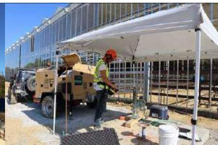
Figura 3 – Primi impieghi dell'argano elettrico mod. PE1250 per cablaggio di conduttori interrati presso un cantiere in USA – 2020
