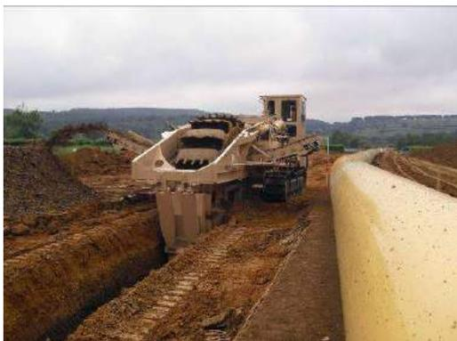
Figura 8 – *Trencher con configurazione a tazze – Bucket*
