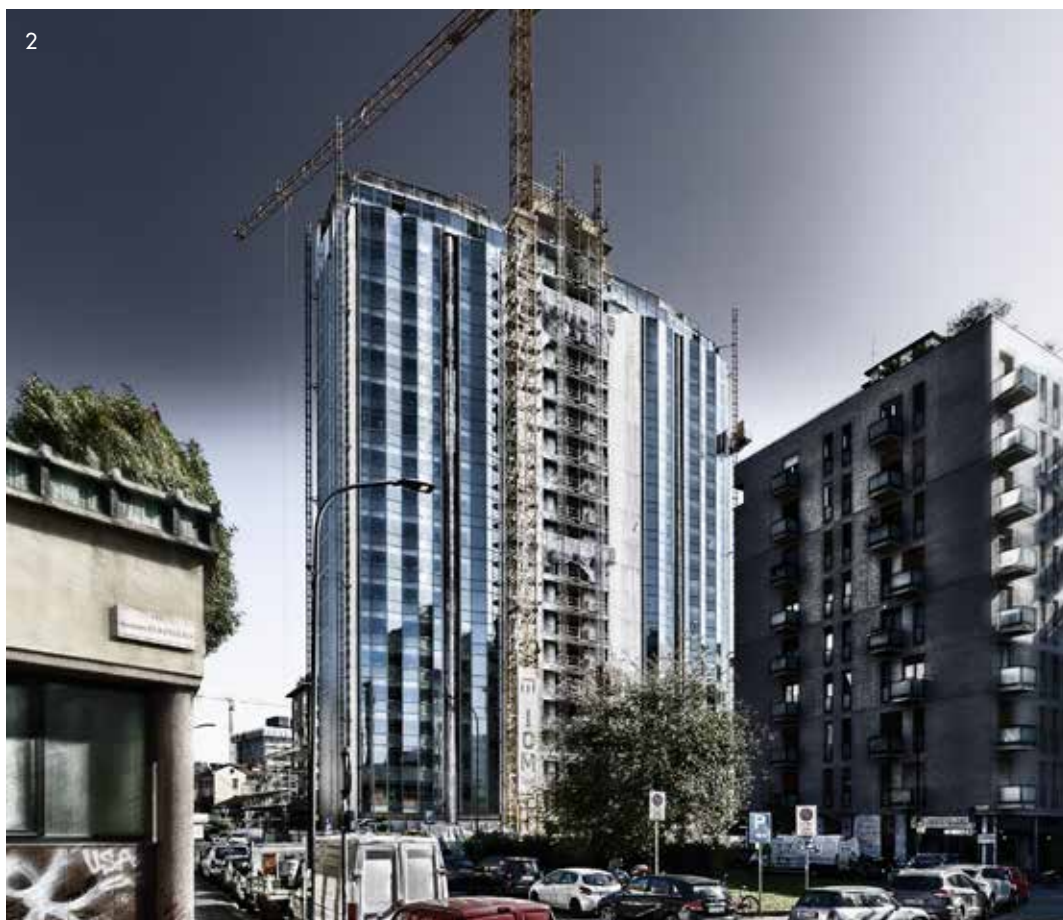
1. Milano, Porta Nuova 2. Milano, Corso Como Place, cantiere
