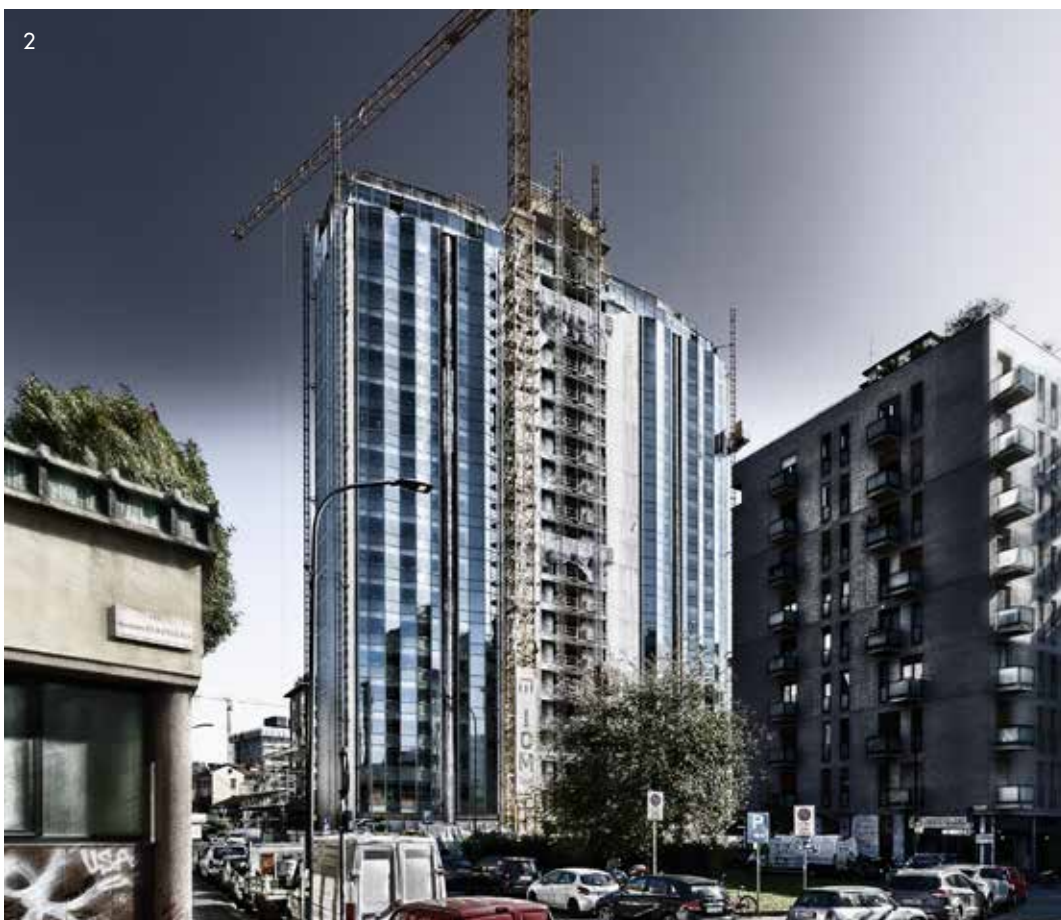
1. Milan, Porta Nuova 2. Milan, Corso Como Place, construction site
