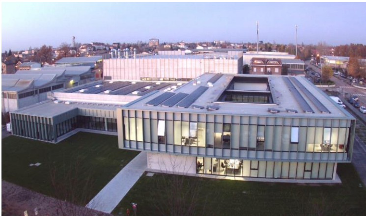
New R&D center (Bagnolo in Piano)
