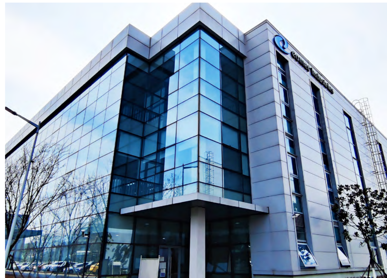
Stabilimento di Comer Industries Jiaxing
