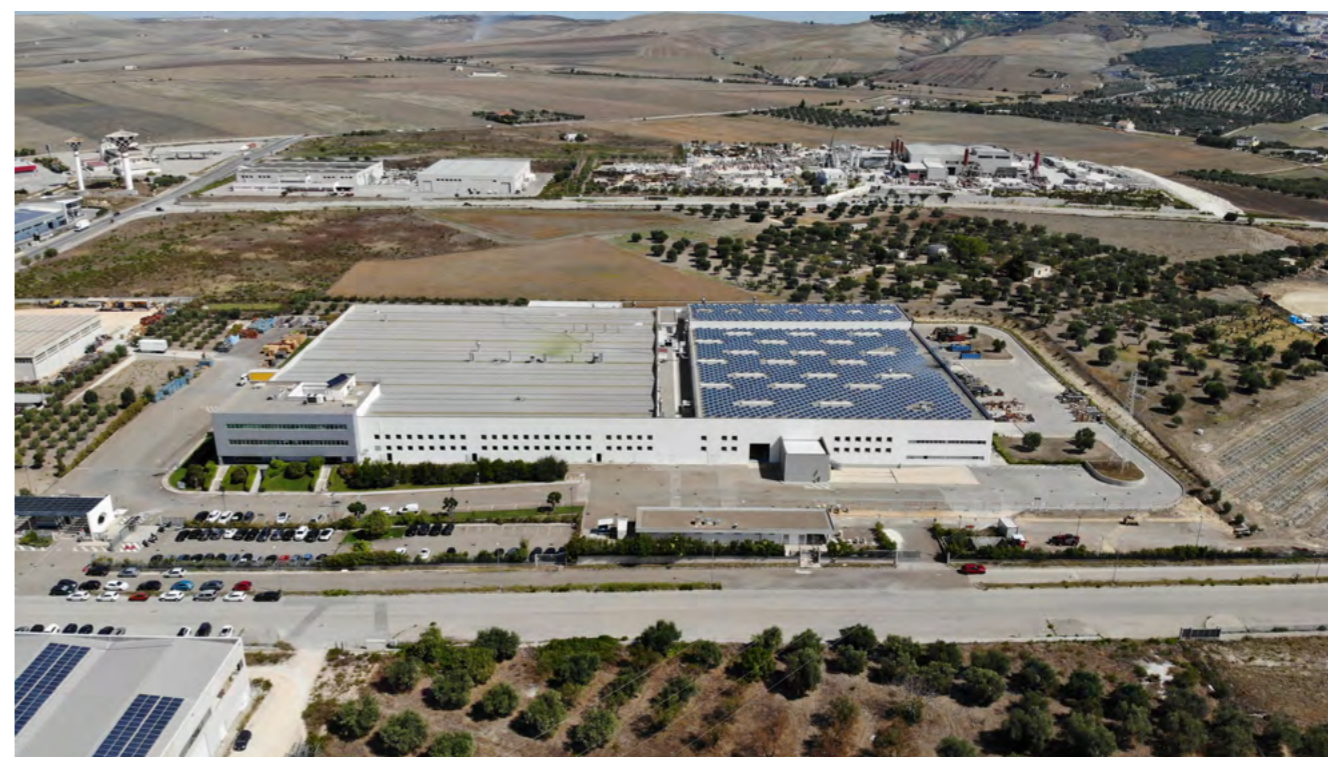
Impianti fotovoltaici nello stabilimento di Comer Industries Components a Matera
