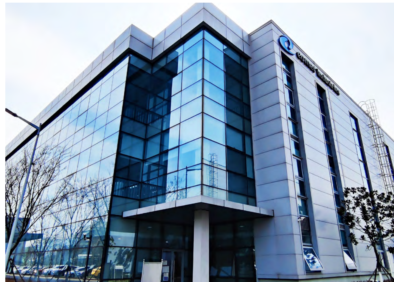
Stabilimento di Comer Industries Jiaxing
