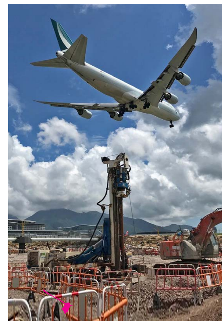
Consolidamenti per il nuovo aeroporto di Hong Kong
