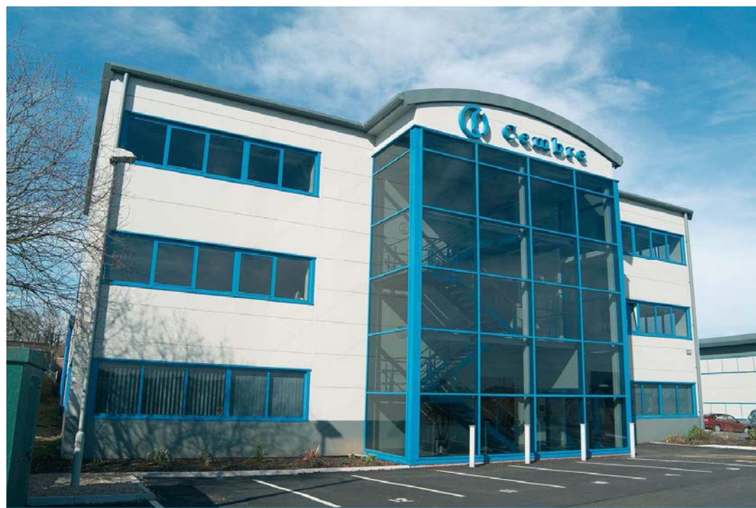
CEMBRE Ltd. – Stabilimento a Curdworth Birmingham (UK)
