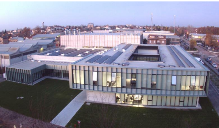
New R&D center (Bagnolo in Piano)
