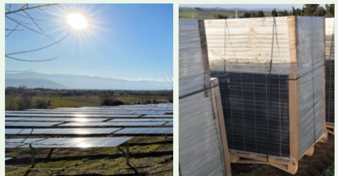
Nelle foto, i pannelli che sono stati smontati dal parco di Stimola e imballati, pronti per essere trasportati nei nostri magazzini e poi essere utilizzati nei progetti Social Purpose.
