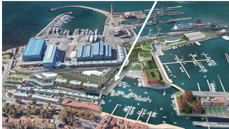
Ingresso Officine Storiche
