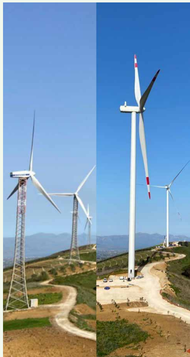
Repowering: prima e dopo
