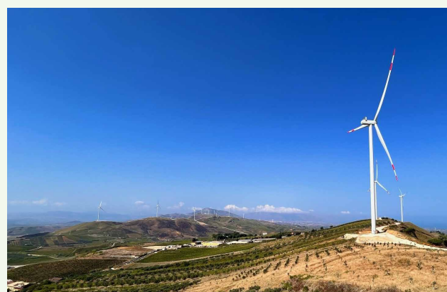
Il nuovo impianto installato a Partinico-Monreale
