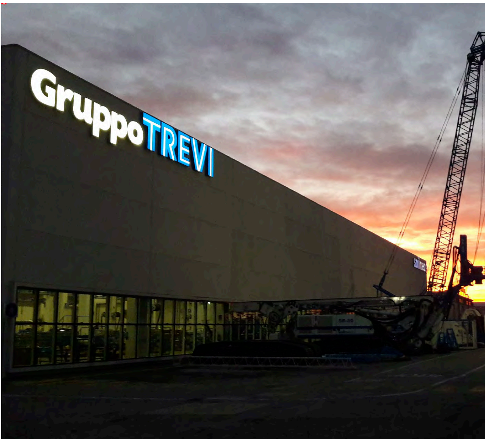
Stabilimento Gruppo Trevi, sede centrale Cesena
