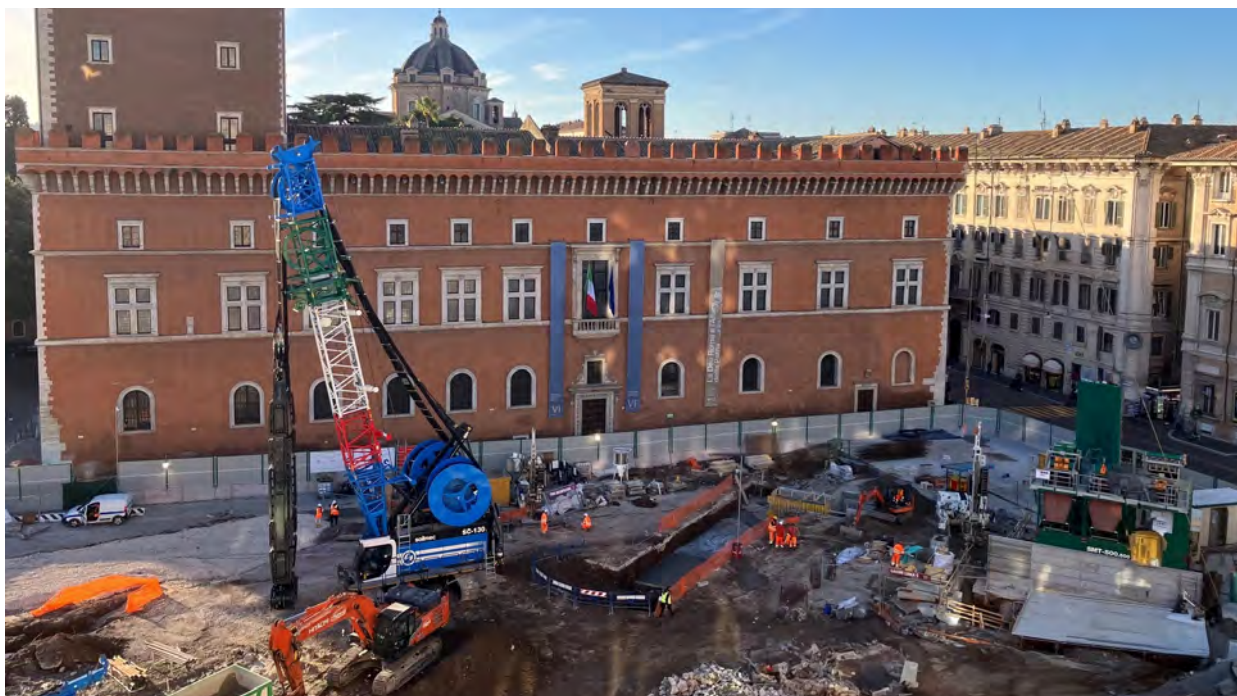
Idrofresa Soilmec SC-130 Tiger in cantiere a Piazza Venezia, Metro Linea C | Roma, Italia
