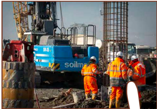
Attrezzature Soilmec vengono testate e messe a punto nei cantieri Trevi prima della produzione in serie
