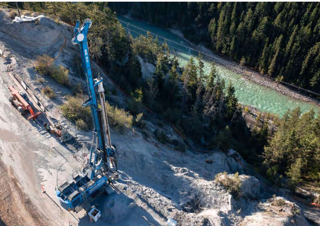
Attrezzatura Soilmec della linea Bluetech, in cantiere.
