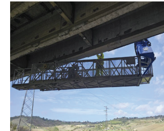
PONTE NELLE ALPI VIADUCT
