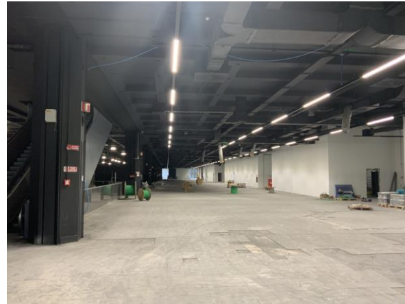
Foto 2 - Balconata Padiglione 1, quota +7 m
