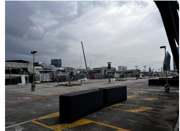
Foto 3 - Parcheggio esterno, quota +15 m
